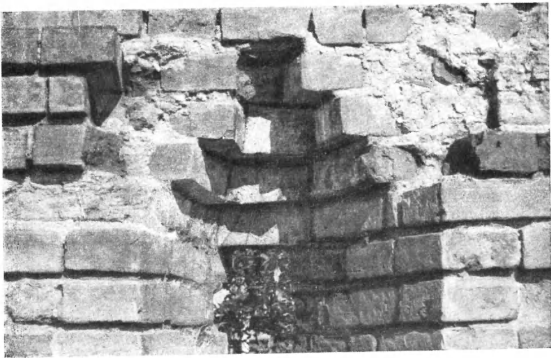
Рис. 12. Перемычки бойниц зубцов стен Тульского кремля
