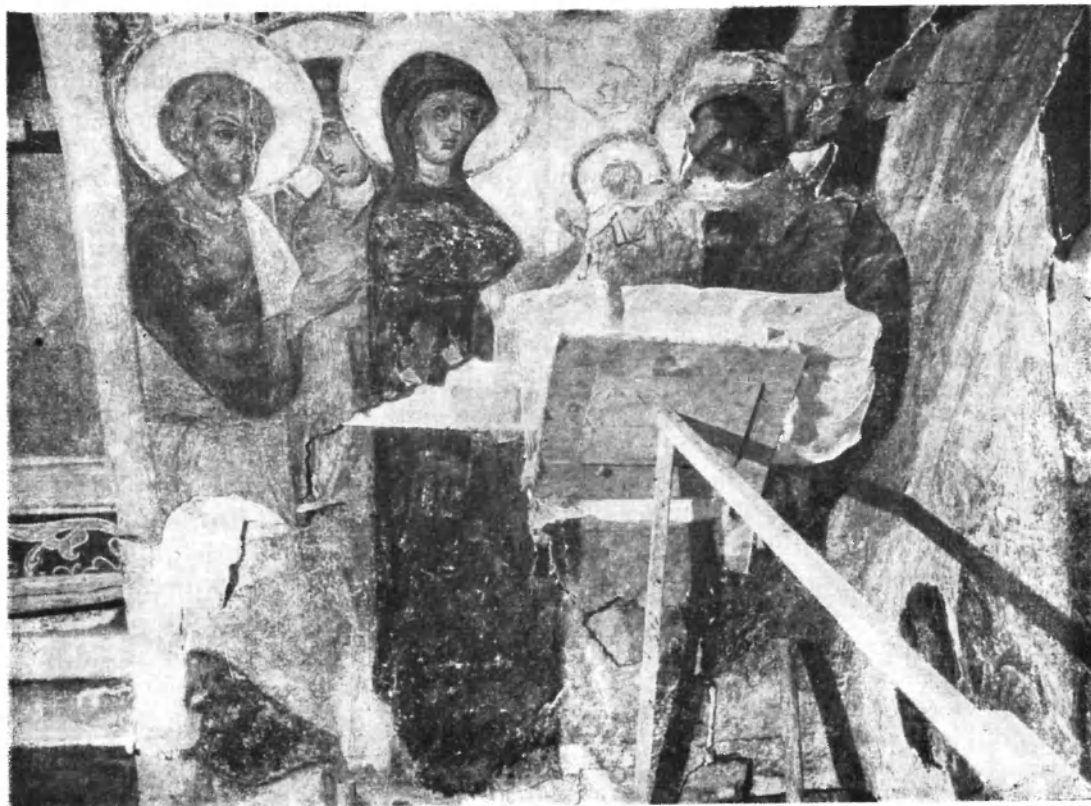
Рис. 4. Троицкий собор. Укрепление арки над южным входом после расчистки стенописи
