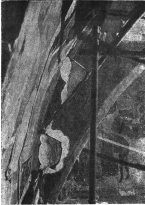
Рис. 3. Троицкий сбор. Южная подпружная арка в процессе укрепления
