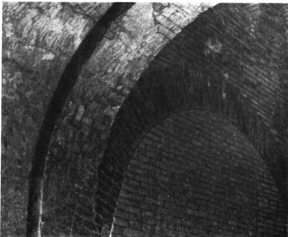
Рис. 21. Щель герсы в арке проезда Пятницких ворот Тульского кремля
