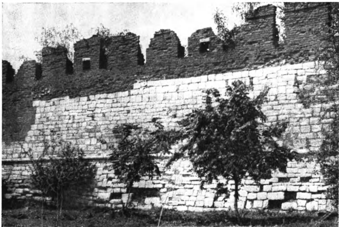
Рис. 7. Фрагмент лицевой стороны юго-западного прясла юго-восточной стены Тульского кремля
