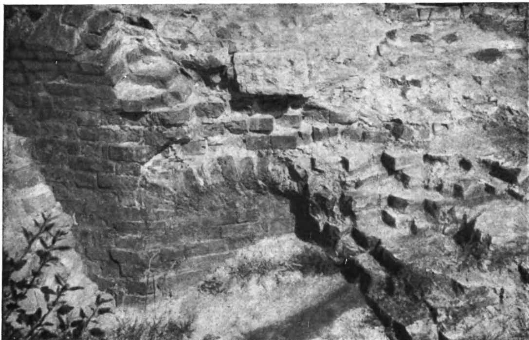
Рис. 33. Остатки арочной перемычки в стене Тульского кремля с северо-восточной стороны Спасской башни
