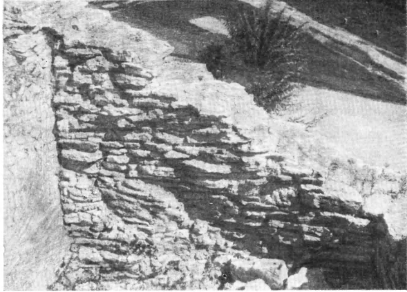
Рис. 2. Церковь Козьмы и Дамиана с Примостья. Один из скатов щипцов. Кладка XV и XVI вв. (фото 1905 г.)
