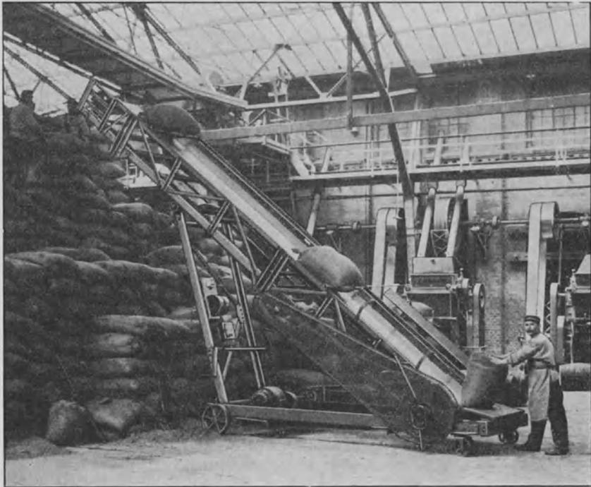
Fig. 281. Fahrbarer Sack-Stapelevator von Luther.
