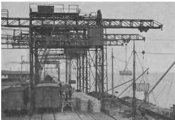
Fig. 434. Bleichertsche Krane mit verschiebbarer Fahrbahn.
