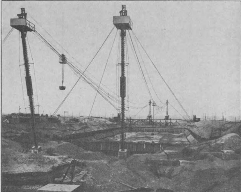
Fig. 480. Schleusen-Kabelkrane mit schwenkbaren Stützen. Bleichert.
