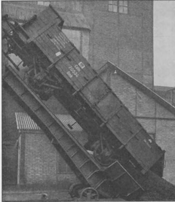
Fig. 81. Niveaukipper mit Druckrollenantrieb.
