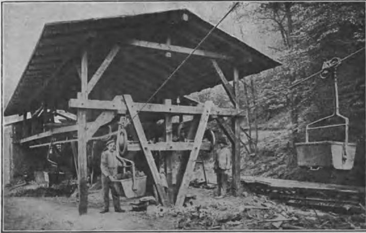
Fig. 268. Beladestation einer Einseilbahn. Bleichert.
