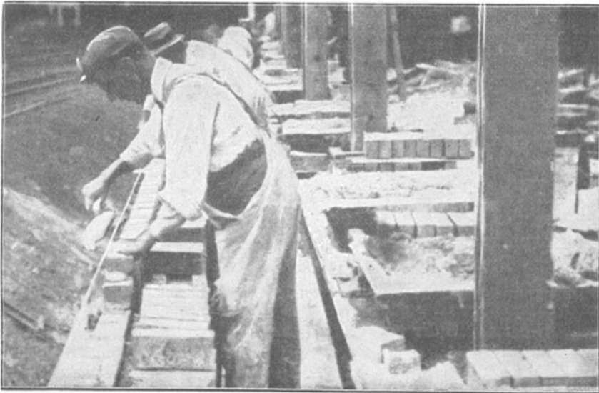
Abb. 67. Das Gilbreth-Gerüst in Betrieb.
