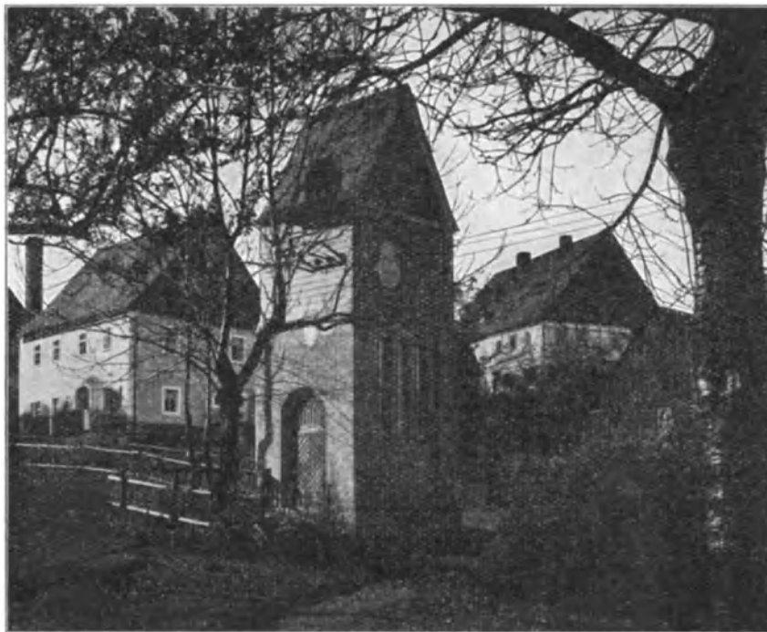
Abb. 365. E.W. Obererzgebirg. Normale Station für eine Hochspannungsausführung, durch Schieferung und Schalung dem Ortsbilde angepaßt. Architekt: W. Issel, Berlin.
