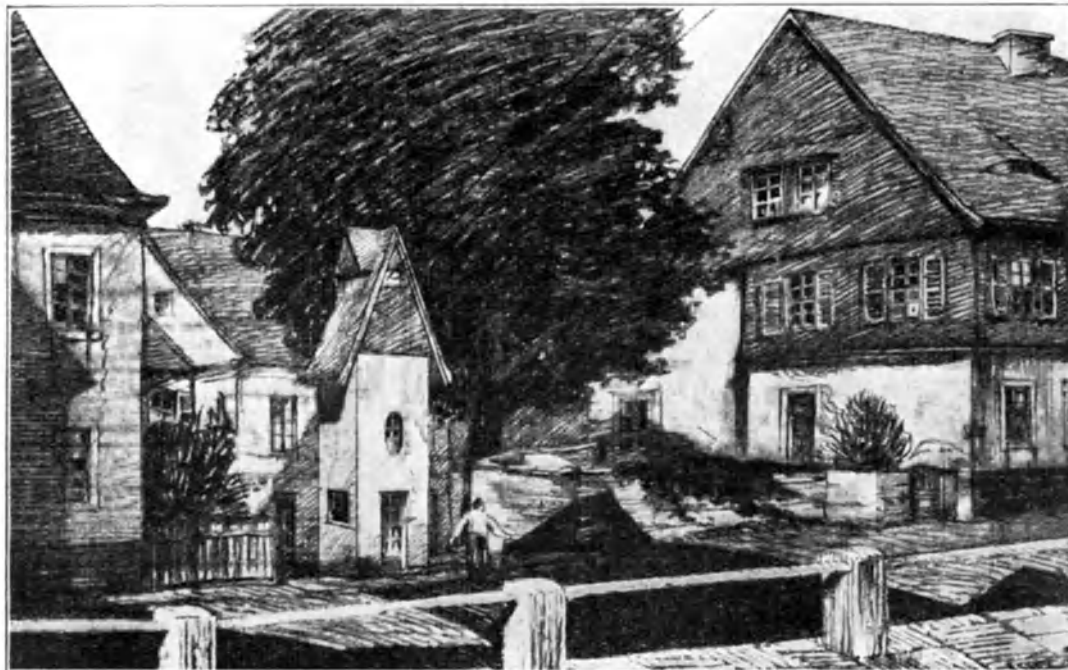
Abb. 358. U.C. Gotha. Kabelstation mit Niederspannungsabgang für Suhl. Die Station liegt zwischen zwei steil ansteigenden Straßen u. ist geputzt u. geschiefert wie die Nachbarhäuser. Architekt: W. Issel, Berlin.
