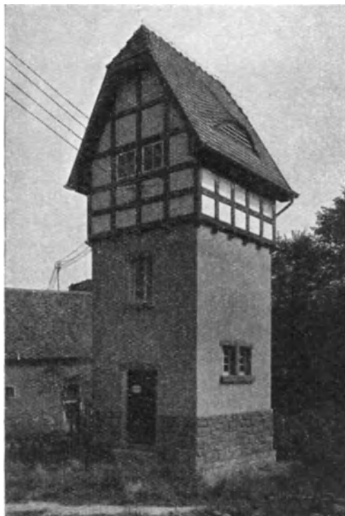
Abb. 361. Gemauerte Transformatorstation für 220 V. Ortsnetz Bad Dürkheim. BBC.
