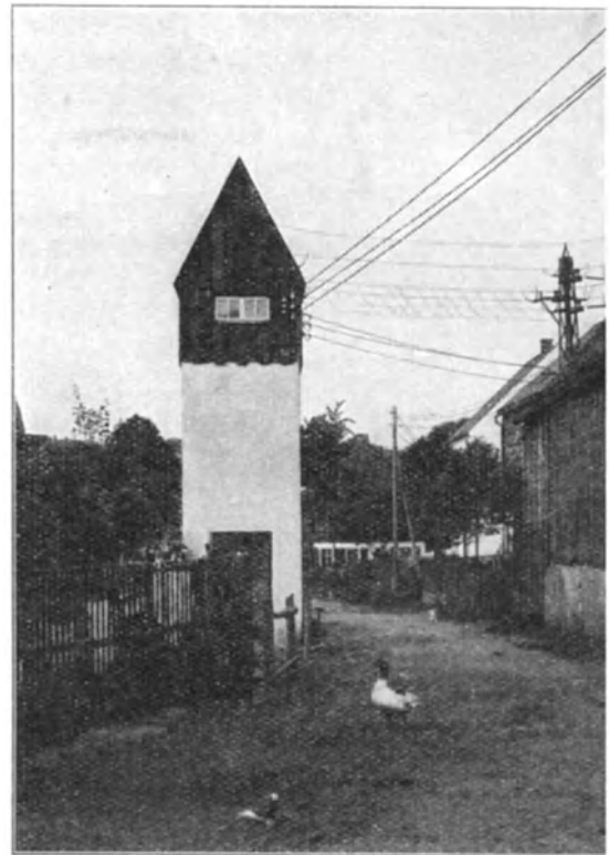
Abb. 364. E.W. Obererzgebirg. Normale Station für eine Hochspannungseinführung und 2 Niederspannungsausführungen.
