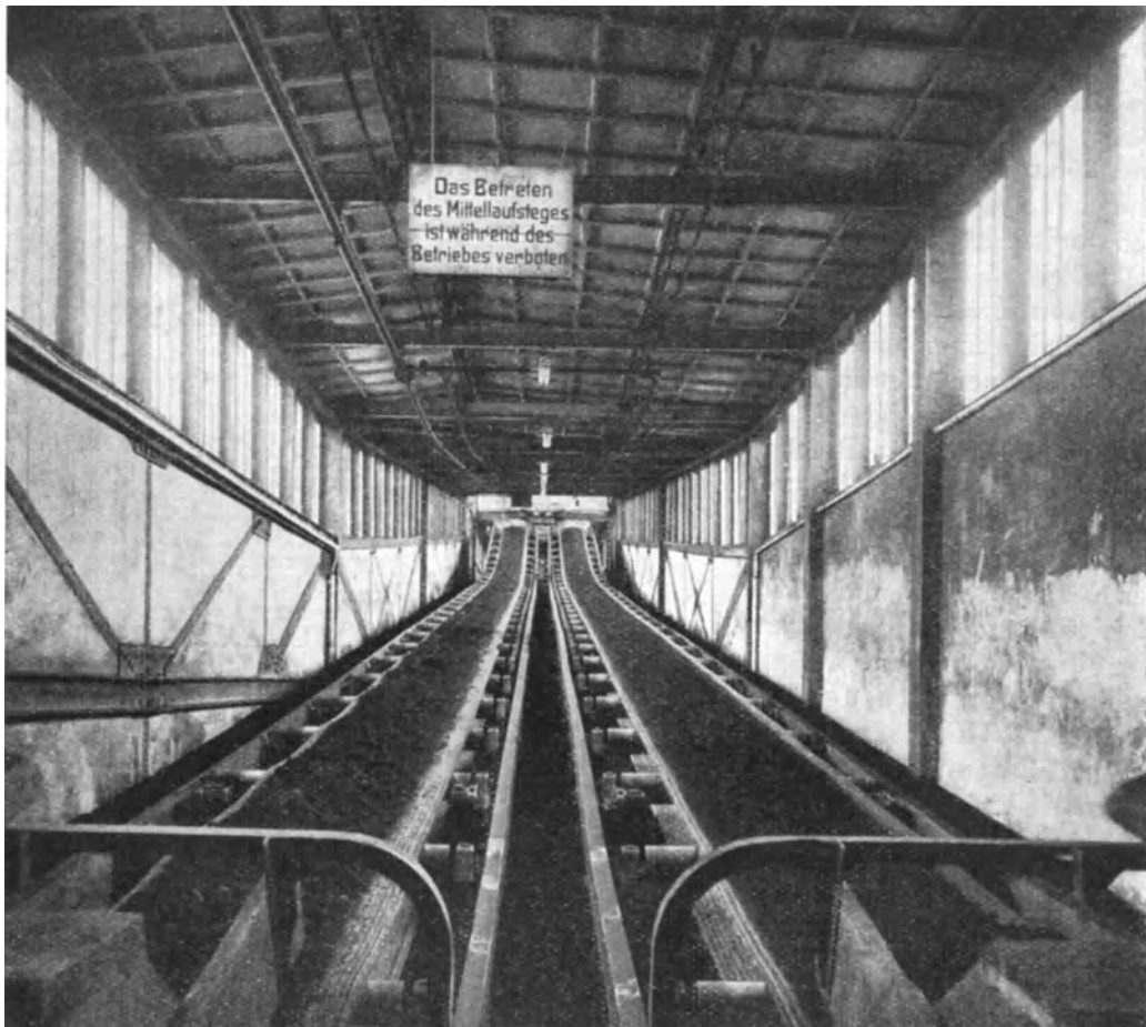
Abb. 681. Quergurte zwischen Turm A und Turm B.
