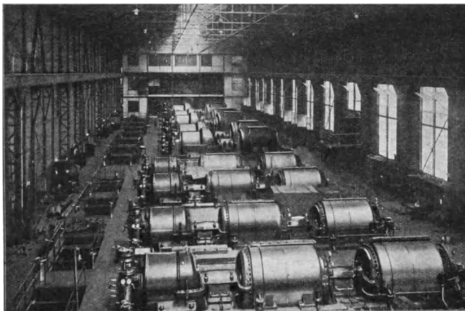
Abb. 597. Kraftwerk Rosherville. Ansicht des fertigen ersten Ausbaues: 5 Generatoren, 4 Kompressoren.
