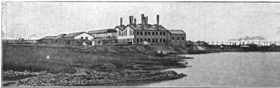
Abb. 565. Kraftwerk Simmerpan. Ansicht. Im Vordergrund Wirtschaftsgebäude; vor den Kesselhäusern der Kohlenbunker.
