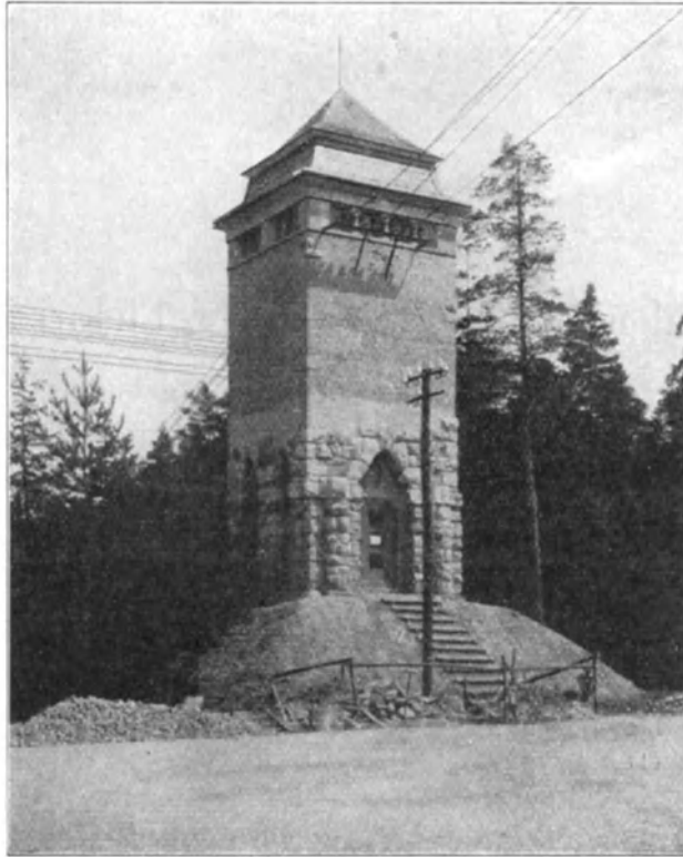
Abb. 373. Elbzentrale. Hochspannungsturm für den Augustusberg Gottleuba. Aus dem Ort entnommener Sandstein, für hervorragenden Aussichtspunkt erbaut. Architekt: W. Issel, Berlin.
