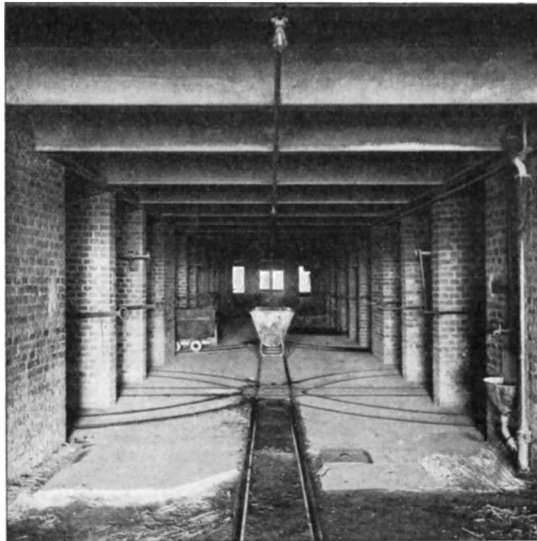
Abb. 413. Einrichtung für den Aschentransport im Keller des E.W. Hirschfelde.
