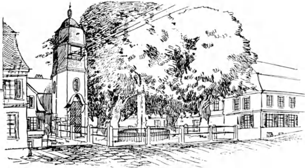
Abb. 353. E.W. Obererzgebirg. Turm für Kabeleinführung und Niederspannungsausführung für den Schloßplatz zu Schwarzenberg. Dem Standpunkt und der Umgebung durch Wahl der Bauformen und Materialien angepaßt. Architekt: W. Issel, Berlin.
