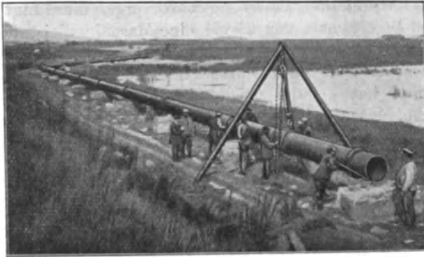
Abb. 619. Druckluftanlage. Verlegung eines 24zölligen Rohres oberhalb des Erdbodens auf gemauerten Pfeilern (sumpfiger Untergrund).
