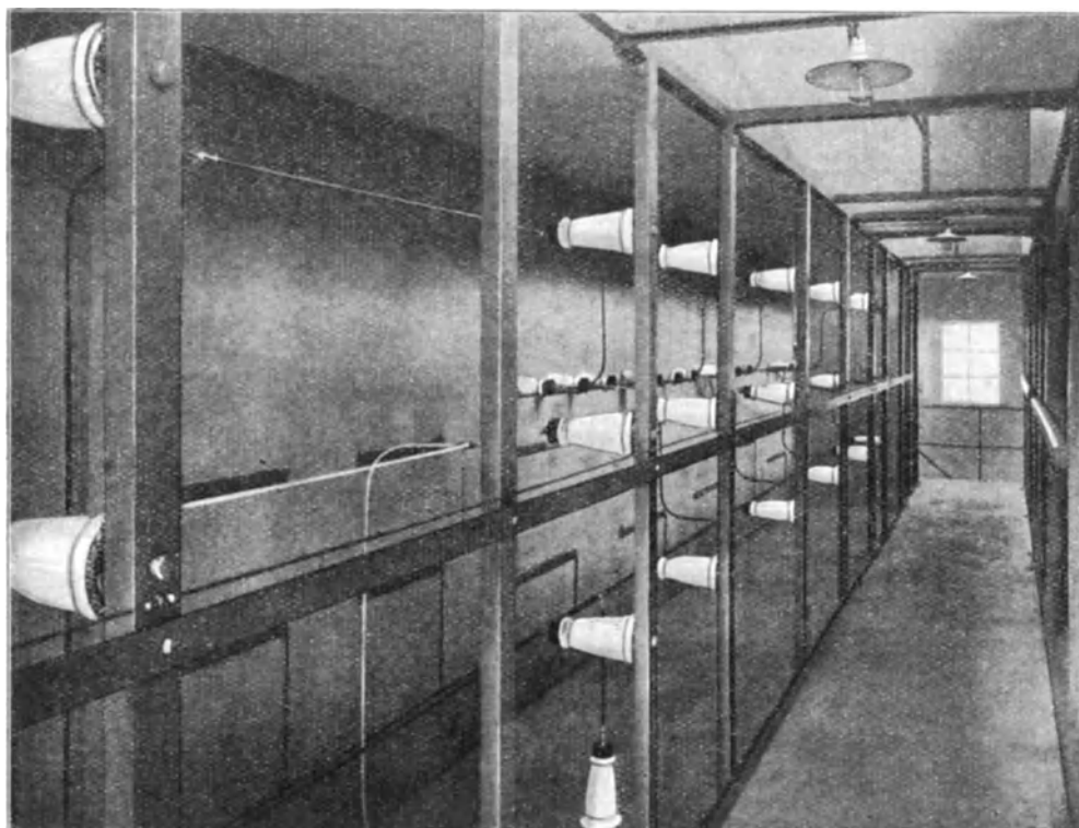
Abb. 301. Anordnung von Hochspannungs-Sammelschienen.
