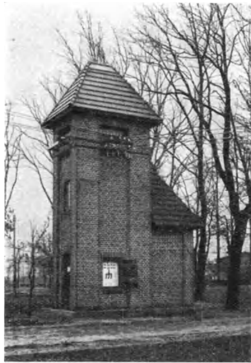
Abb. 369. Gemauerte Transformatorstation. Ü.W. Uelzen. SSW.
