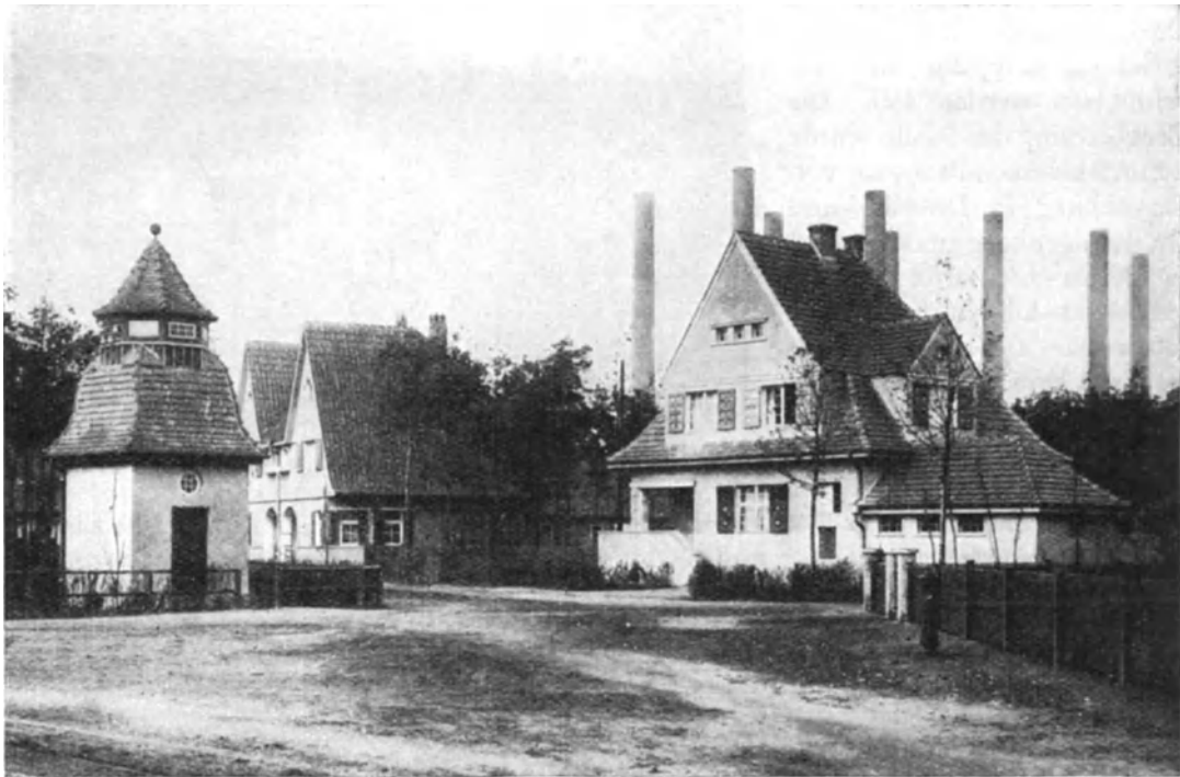
Abb. 770. Platz mit Transformatorhäuschen, Beamtenhaus und Kraftwerk im Hintergrund.
