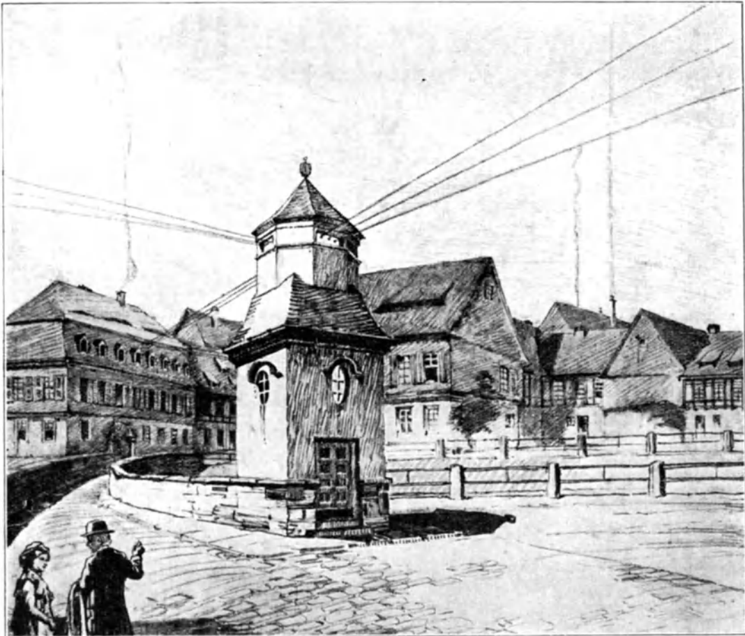
Abb. 357. U.C. Gotha. Kabeleinführung und Niederspannungsausführung nach vier Seiten. Station ist als Brückenkopf für Suhl ausgebildet. Architekt: W. Issel, Berlin.
