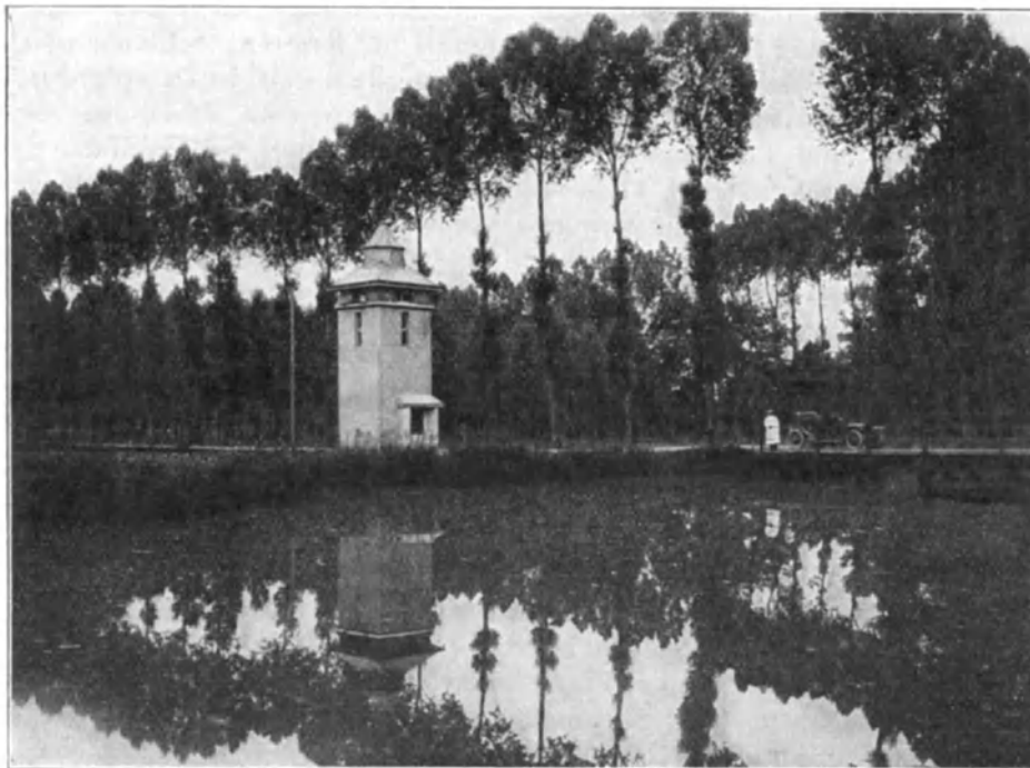
ob. 374. E.W. Bergheim. Turm für je 2 Hochspannungsleitungen. Architekt: W. Issel, Berlin. klingenberg, Elektrizitätswerke. 3. Aufl.
