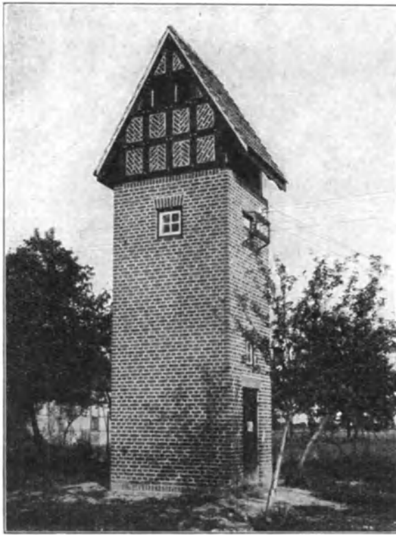
Abb. 370 u. 371. U.S. Salzwedel. Normales Haus für eine Hochspannungsausführung. Fachwerk und Rohbau, wie die angrenzenden Dorfbauten. Architekt: W. Issel, Berlin.
