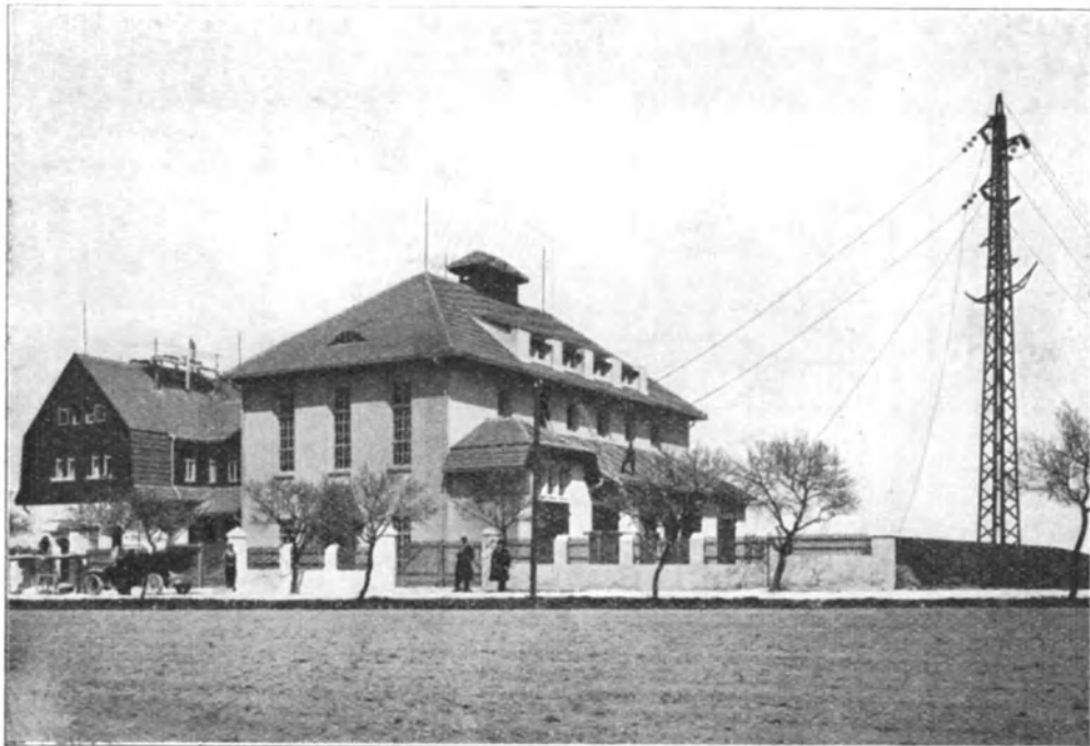
Abb. 312. C.V. Gröba. Große Transformatorstation für 60 000 V. Bergmann-Elektrizitäts-Werke.
