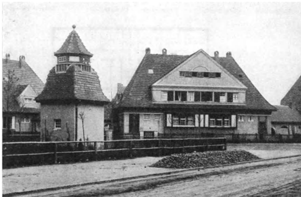
Abb. 767. Platz mit Betriebsleiterhaus und Transformatorenhäuschen.
