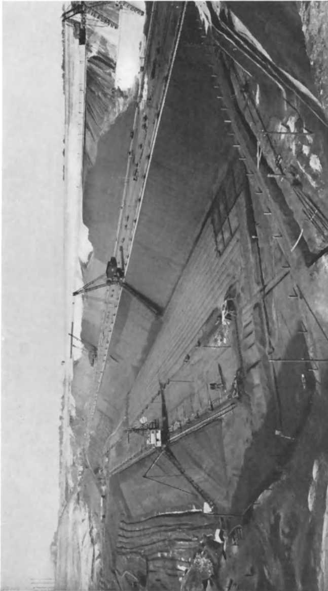
Abb. 58. Neuzzeitlicher Braunkohlen-Tagbau (Weichbraunkohle). Grube Leonhardt, Geiseltal. Die in diesem Bild noch sichtbaren Kettenhunte sind inzwischen ziemlich allgemein durch Großraumbahnen mit schwersten Elektrolokomotiven ersetzt worden. Aufn. Michelwerke.
