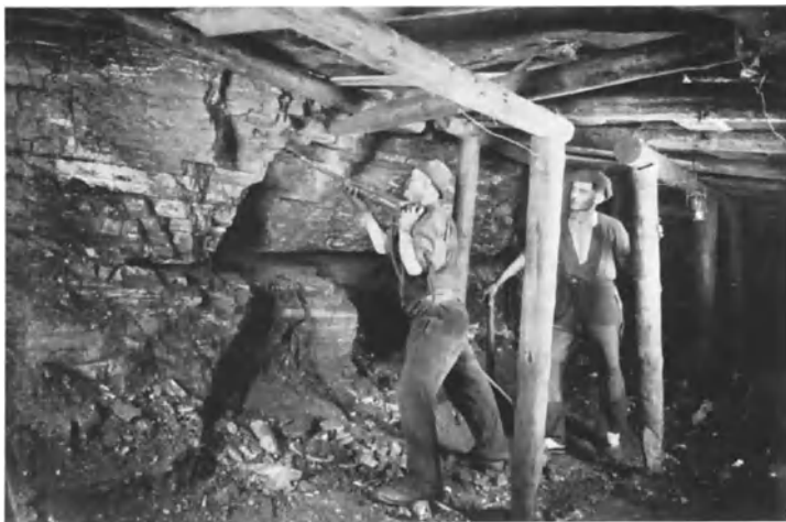
Abb. 56. „Vor Ort“ in einem oberschlesischen Steinkohlenbergwerk (im Strebbau mit Bohrhammer). Aufn. Max Steckel, Gleiwitz.
